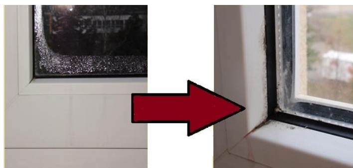
Obrázek 1 vznik plísně u plastových oken
