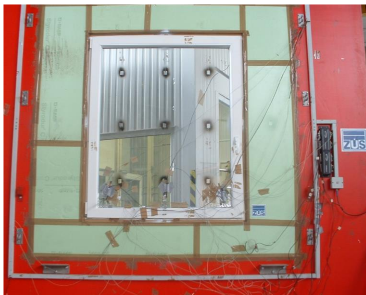
Obrázek 2 Měření vnitřních povrchových teplot
